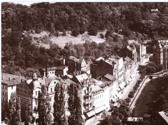
Chebská ulice na pravém břehu Teplé kolem r. 1935
